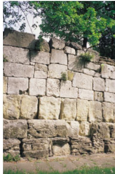
Reste der mächtigen Lagermauer aus römischer Zeit kann man noch heute sehen.
